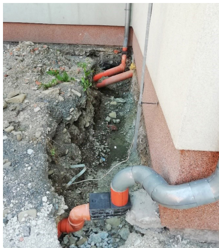
Povrchové vody ze střechy
