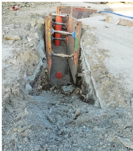
Napojení povrchových vod z parkoviště.
